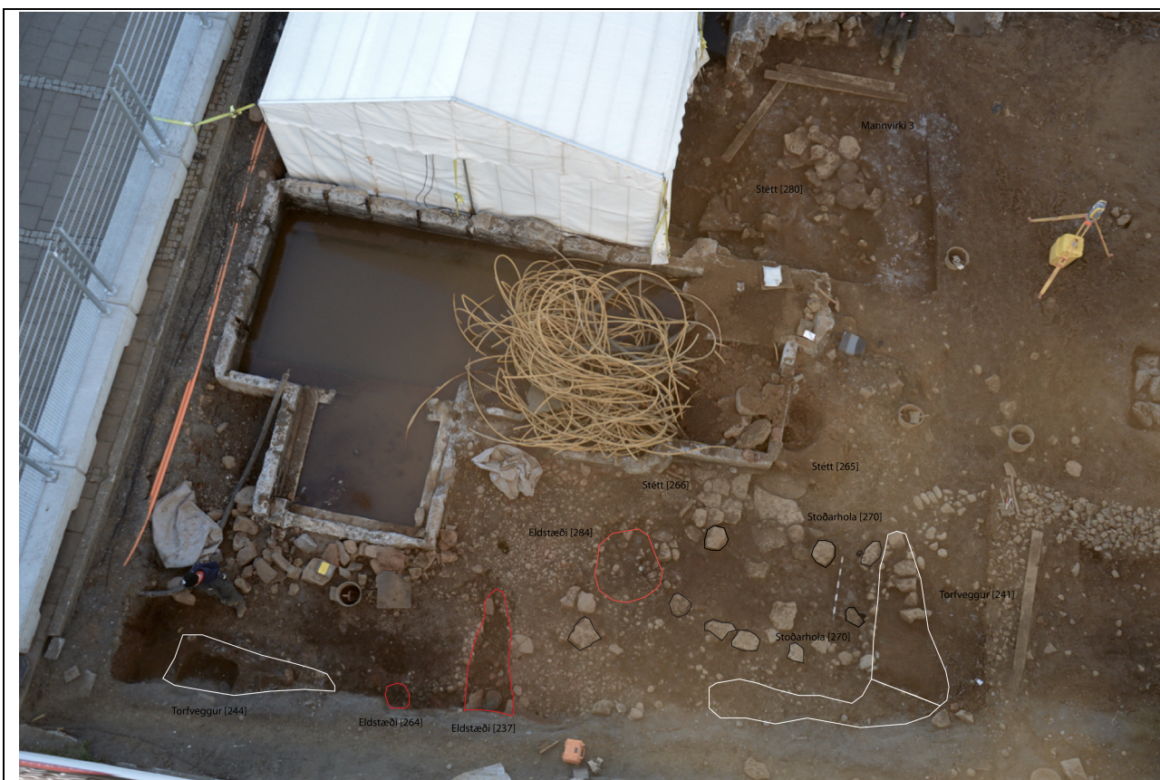
Mynd 89 Loftmynd af mannvirki 2 og 3.
