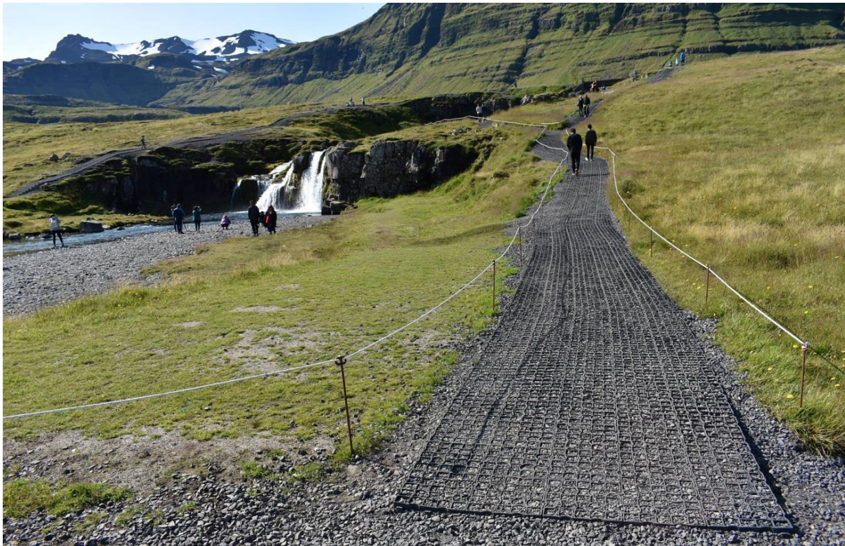
Nýlegur göngustígur úr plastgrindum. Kirkjufellsfoss Snæfellsnesi 2017/DAS
