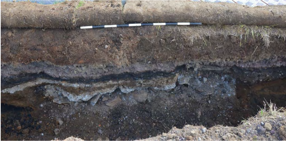
Mynd 10. Steypt plata [308] og blæðsla [309] úr óþekktu mannvirki. (Ljósmynd Lilja Laufey Davíðsdóttir).
