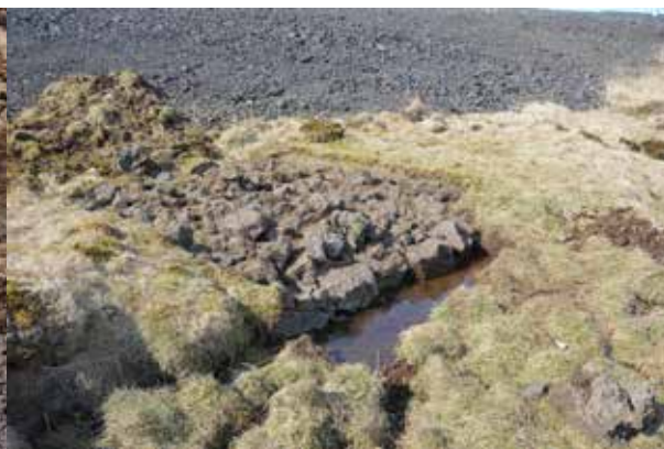
Mynd 11. Hér sést hvernig vatn safnaðist að Steinboga eftir að búið var að hreinsa hleðsluna.
