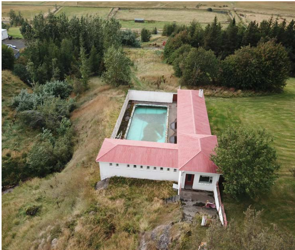
Mynd 8: Sundlaugin að Syðra-Laugalandi. Saga laugarhalds á þessum stað er nokkuð löng og líklega var eitt fyrsta laugarhúsið við sundlaug reist á þessum stað 1874 þegar Framfarafélag Öngulstaðahrepps veitti bæjarlækninum í sundstæði í litilli laut sem blaðið hafði verið fyrir og byggði laugarhús. Líklega voru hús og laug ekki mjög lengi í notkun en ný sundlaug og laugarhús voru byggð á þessum slóðum 1932 af UMF Áróðanum og UMF Arsól. Laugarhúsin voru svo rifin og ný gerð 1964. Arkitekt laugarinnar frá 1964 var Guðmundur Guðjónsson/ Húsameistaraskrifstofu ríkisins. Ljósmynd: Elín Ósk Hreiðarsdóttir.
