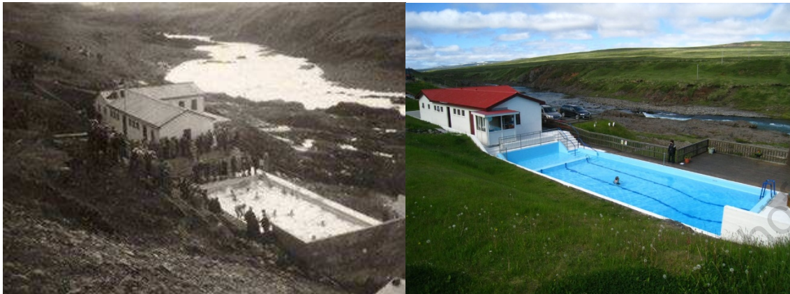
Selárdalslaug. Myndirnar birtust á vef Ungmennafélagsins Einherja í tilefni af 70 ára afmælis laugarinnar 2020 og er önnur frá formlegri vígslu laugarinnar 1950 en hin nýleg. https://www.einherji.net/frettir/70-ar-fra-vigslu-sundlaugarinnar-i-selargljufurum
