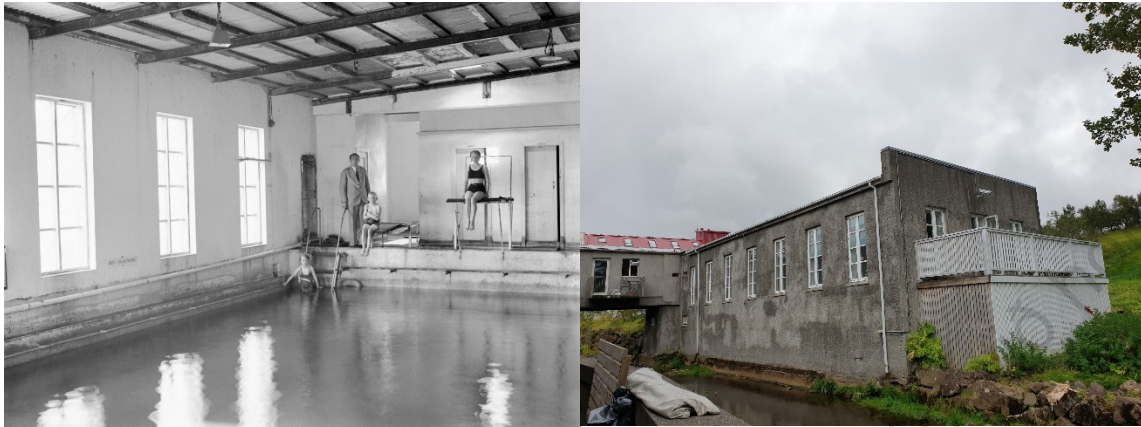
Mynd til vinstri Álafosslaug vígð 1933 af https://skjalavefur.bermos.is . Mynd til hægri tekin af húsinu 2022.
