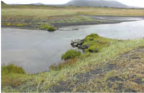
Leifar brúar NP-068:019 við Klapparhamra.
