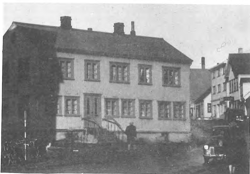
Vesturgata 7. Reykjavík. (Sjóbúð) hús Geirs Zoega. Fyrsta húsið sem þakið var með bárujárni (þakjárn) 1884 segir, í Iðnsögu Íslands. — „járníð var nr. 20 og sá lítt á því eftir 50 ár.“
