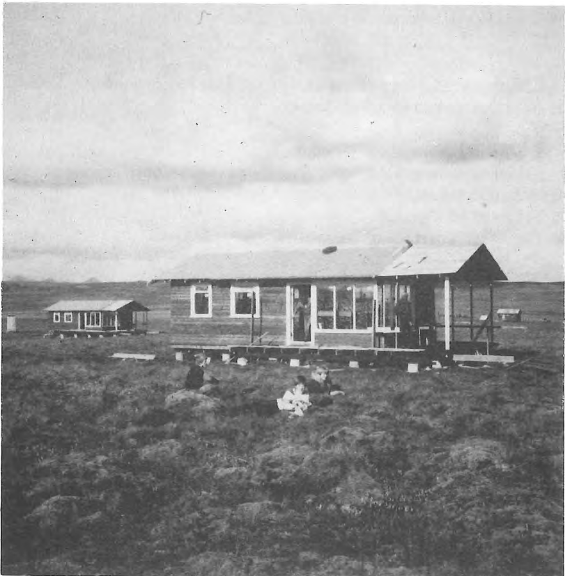
Tvö orlofshús í byggingu vorið 1980 í landi félagsins að Klausturhólum, Grímsnesi í baksýn má sjá Kálfatinda.
