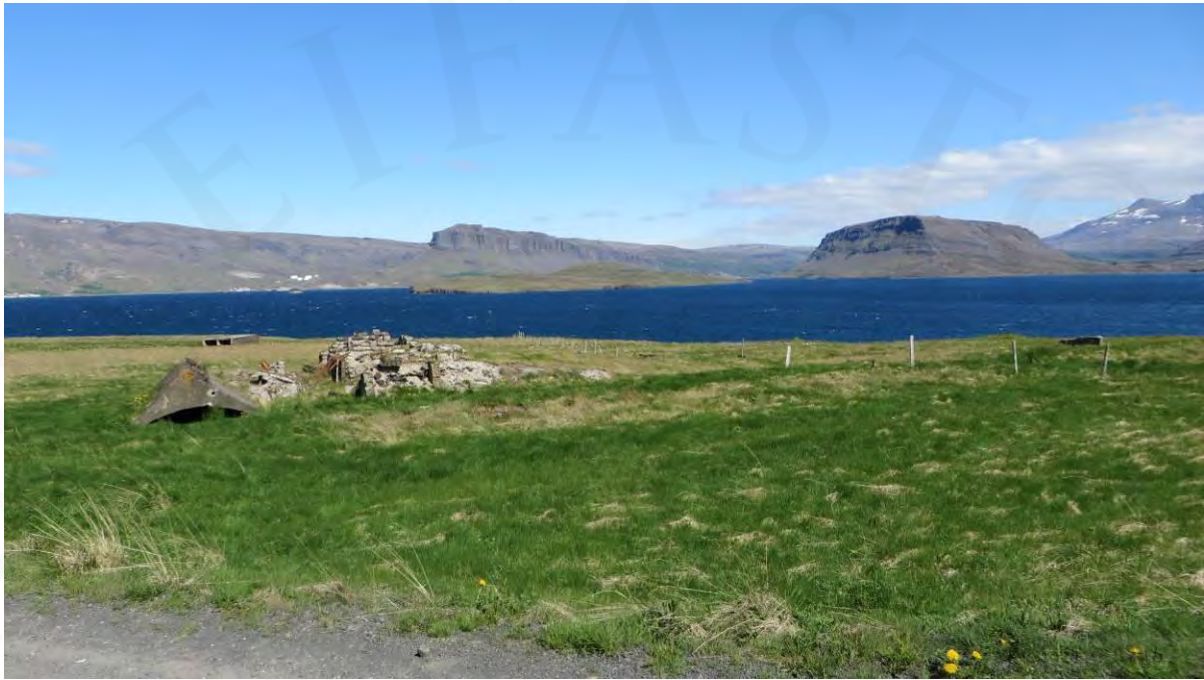
Mynd 16: Mannvirki GK-355:061, horft til NNA. Ljósmynd tók Gylfi Helgason.
