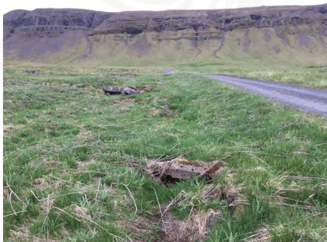
Mynd 8: Fallnar undirstöður ljósastaur GK-355:032_05 norðan við brunn 355:035, horft til suðurs. Ljósmynd tók Gylfi Helgason
