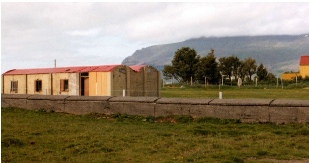
Fjárhúsin í Meltúni. Upprunalega hlaðnar músteinsbyggingar með bogabaki frá hernámsárunum. Íbúðarhúsið til hægri. Fremstur er hitaveitustokkurinn. Ljós. Bjarki Bjarnason, 1977.
