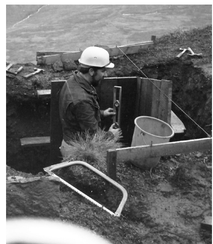
Efri lyftan í byggingu. Guðmundur varði drjúgum tíma til þessa verks sumarið og haustið 1971.
