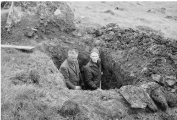
Frá byggingu efri lyftunnar á Seljalandsdal, Guðmundur Sveinsson og Gunnlaugur Jónasson. Ljós. GÁ.
