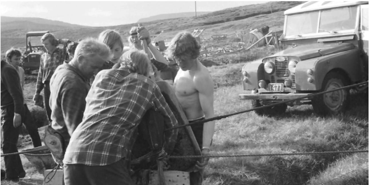
Frá byggingu efri lyftunnar á Seljalandsdal. Ljós. GÁ.
