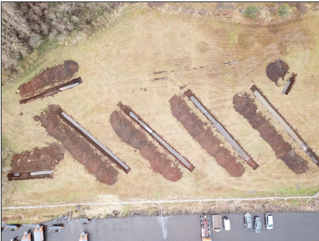
Mynd 27. Horft yfir skurði 3 og 4 (skurð 4.3 vantar á mynd). Á ljósmyndinni má sjá að skurðirnir eru fullir af vatni en það einkenni skurðina á þessu svæði.
