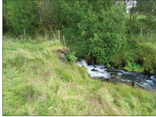
Stífla RA-205:008_2, horft til austurs.
