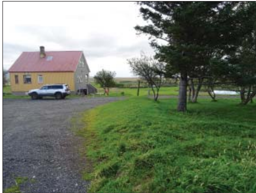
Hleðsla RA-202:050, horft til suðurs.
