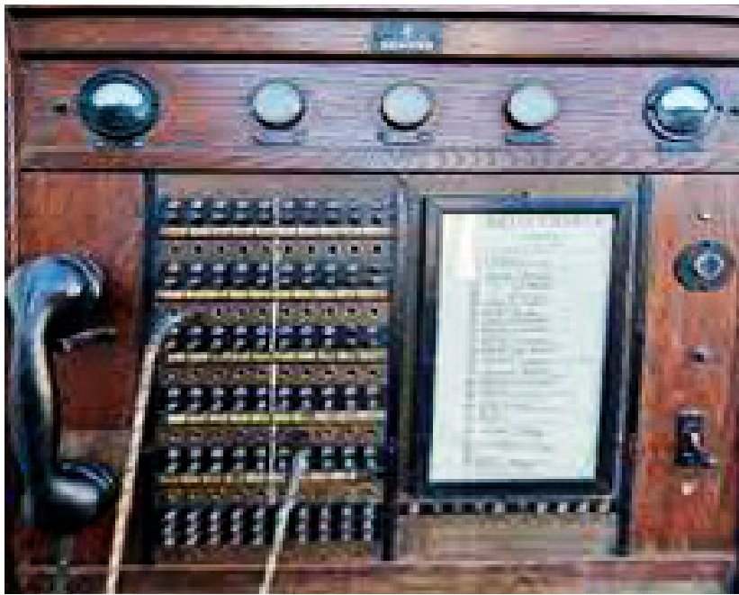
Móttökutæki á slökkvistöðinni fyrir upphringingar frá brunaboðum víða um bæinn.
