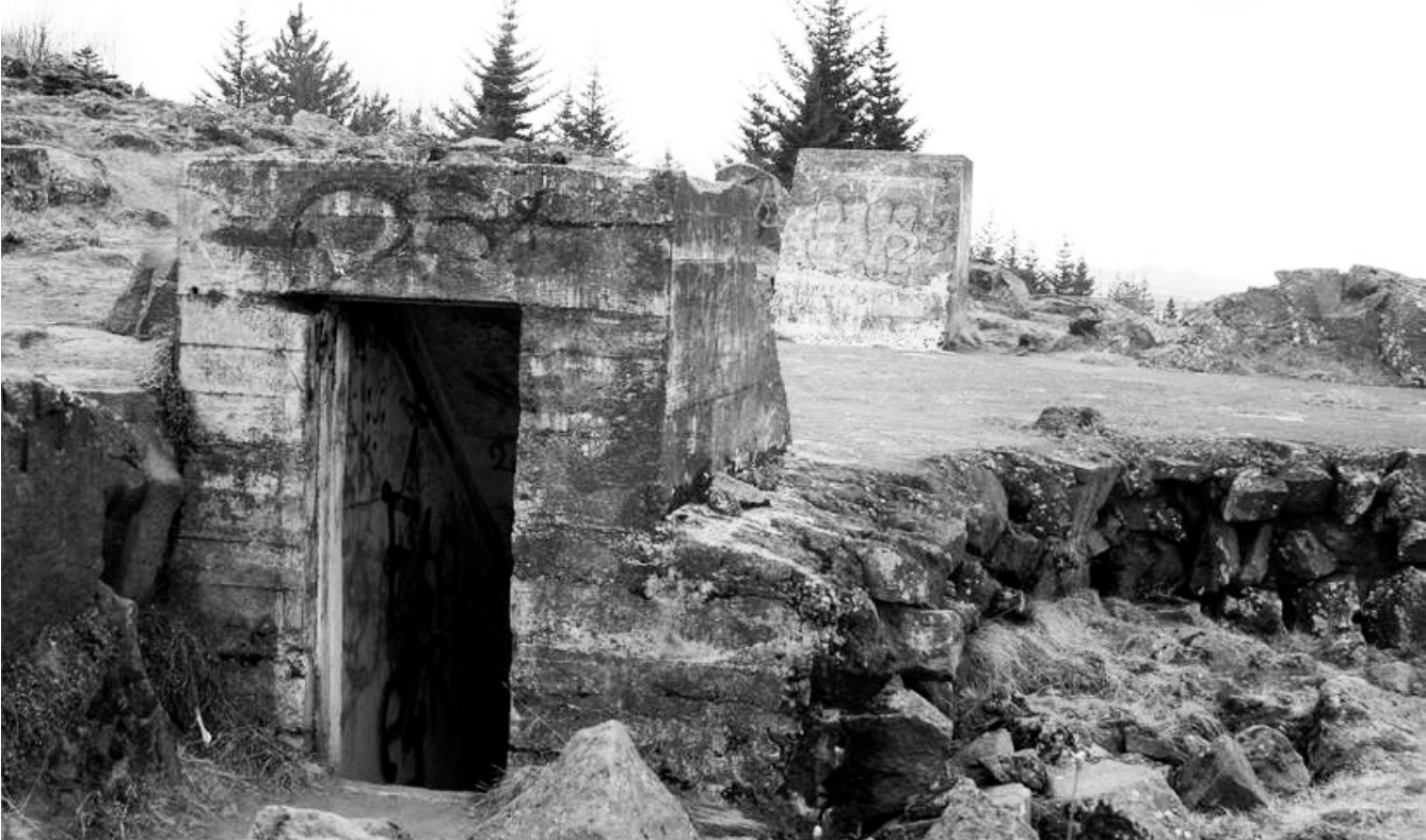
Dularfull neðanjarðarmannvirki sem byggð höfðu verið í Öskjuhlíðinni í stríðinu sköpuðu óttablandna spennu.
