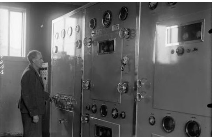
Sendir endurvarpsstöðvarinnar á Eiðum, sem þjónaði austanverðu landinu og nærliggjandi hafsvæðum. Stöðin var tekin í notkun árið 1938.
