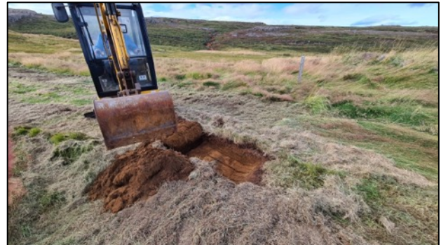
Mynd 8. Horft til suðvesturs yfir skurð 2021-sk. 1.
