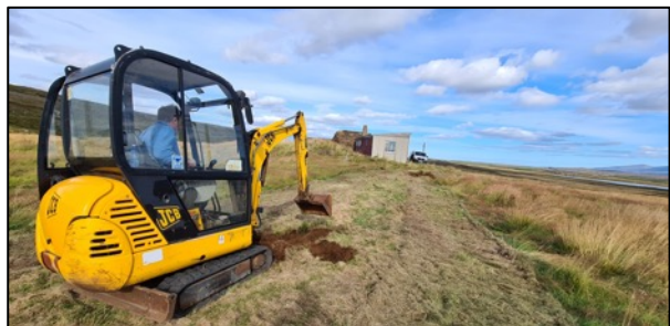
Mynd 9. Horft til norðurs yfir skurð 2021-sk. 2.
