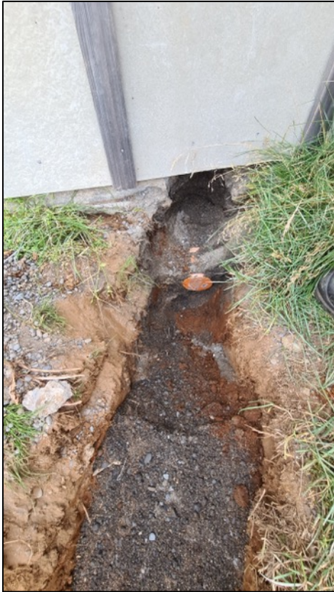
Mynd 5. 2021-lagnaskurður. Horft til vesturs yfir malarlag sem lá yfir steyptri frárennislögn frá 1962.
