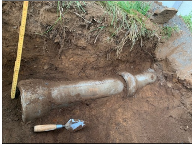
Mynd 6. Horft til suðurs yfir suðurprófil í 2021-lagnaskurði.
