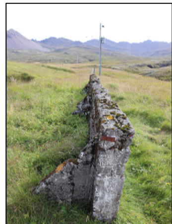
Mynd 12. Horft til suðurs yfir steypuvegg 2795-7.
