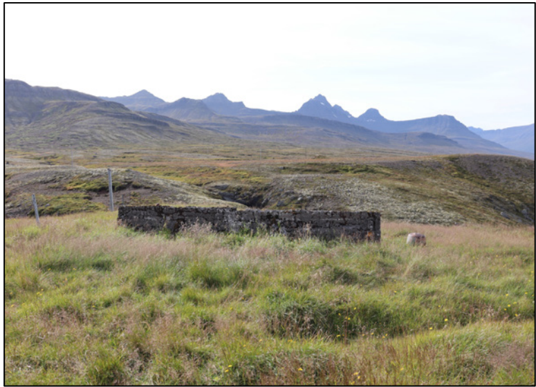
Mynd 11. Horft til V yfir steypuvegg 2795-7.
