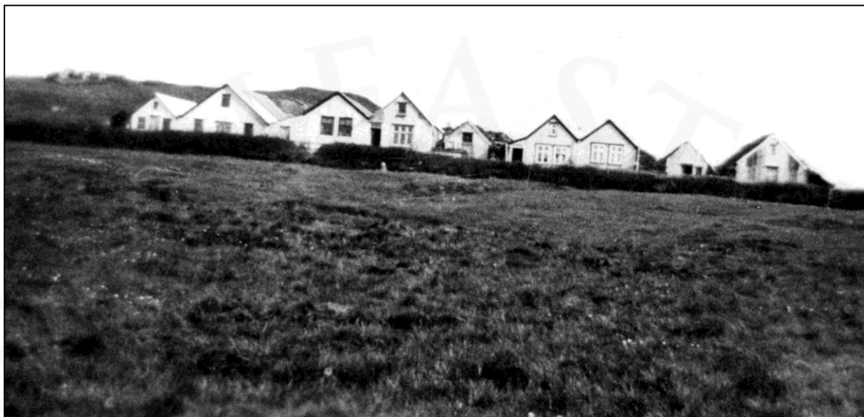
Mynd 2: "Gröf fyrir 1930. Burst, sem er 5. frá vinstri var rifin eftir 1930, ný burst byggð á sama stað".-Ljósmynd fengin hjá Guðrúnu Emilsdóttur apríl 2021. Horft til norðurs.
