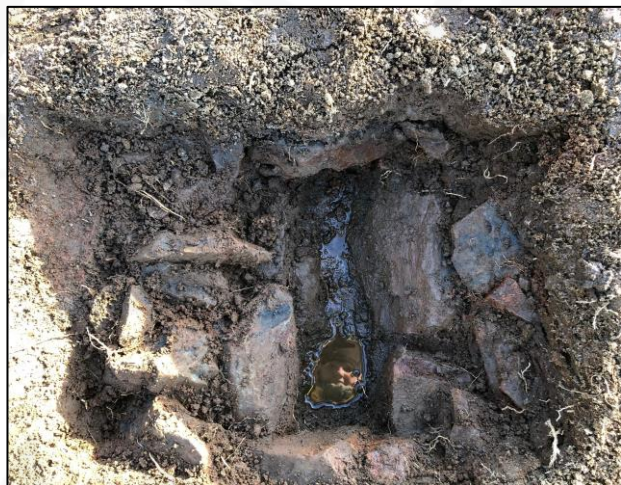
Mynd 42: Ræsiholan fullgrafin. Grjótrenna en hér er búið að fjarlægja grjóthellu sem lá yfir rennunni sjálfri. Horft til vesturs.
