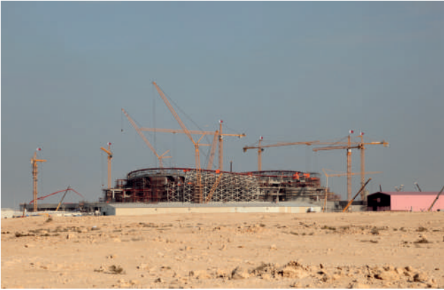
Framkvæmdir við nýjan leikvang nærri borginni Lusail í eyðimörkinni í Qatar.
