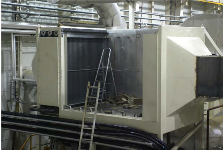
Mynd 13: Hitakassinn í uppsetningu án rafelementa.
