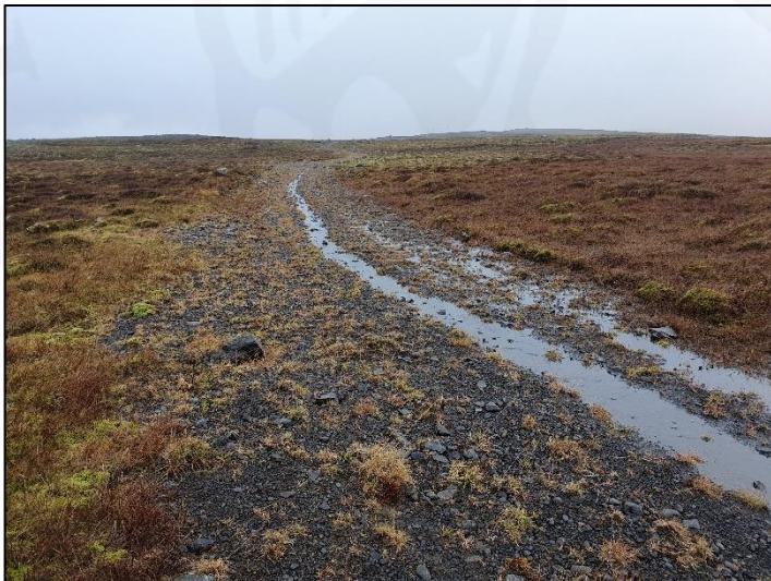
Leið 641:002 01, horft til austurs.
