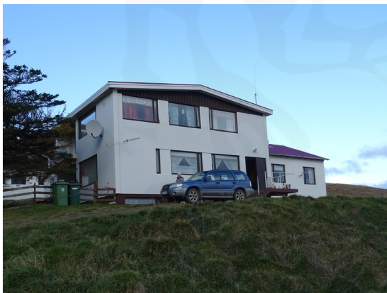
Bæjarhóll HV-107:001, horft til norðvesturs.
