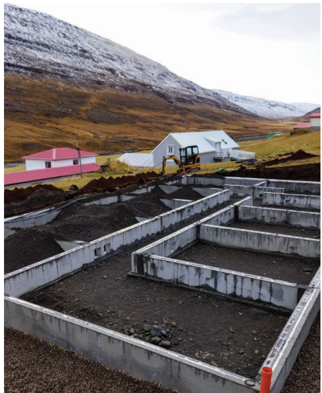
Hótelbygging að rísa við Óbyggðasetur.
