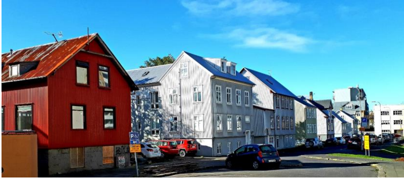
2022. Suðurhlíð Lindargötu frá Frakkastíg 62 að Frakkastíg.
