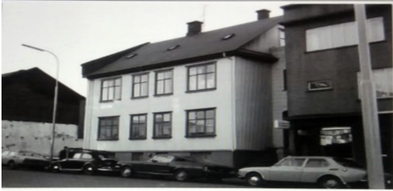
Hverfisgata 28, byggt 1905. Sigríður Zoega starfaði þar sem ljósmyndari. Endurbyggt að hluta 2017 með viðbyggingu við Hverfisgötu 26 (Sparisjóður Reykjavíkur og Regnfatabúðin).
