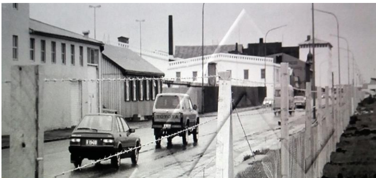
1986, Skúlagata, hvíta húsið stóð við Vatnsstíg þar sem Skuggi I er nú, Færeyingaheimilið og SS eru til vinstri og Útvarphúsið háa hvíta byggingin lengst til hægri / Ljósmyndasafn Reykjavíkur.
