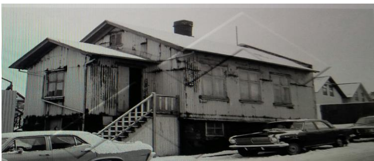
Vatnsstígur 16A er norðan við Lindargötu. Húsið er til á teikningum frá 1905 sem hús Jóns Jónssonar, ein hæð, ris og kjallari. Húsið og lóðin var síðar í eigu Eimskipafélagsins. Á þessum lóðum standa nú háhýsi í áfanga Skugga II.
