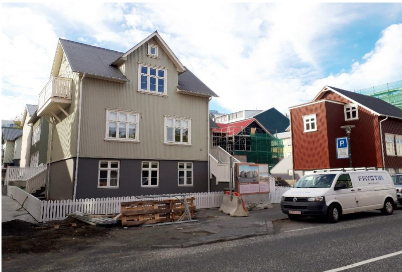
2022. Endurbyggð Hverfisgata 86 og 84 (til hægri). Endurbyggt hús við Vitastíg 7 í baksýn.
