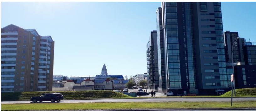
2019. Vatnsstígur frá Sæbraut. Hér stóð áður færeyska sjómannaheimilið. Á þessum reit fyrirhuga borgaryfirvöld að byggja háhýsi sem að margra mati yrði skipulagslys.
