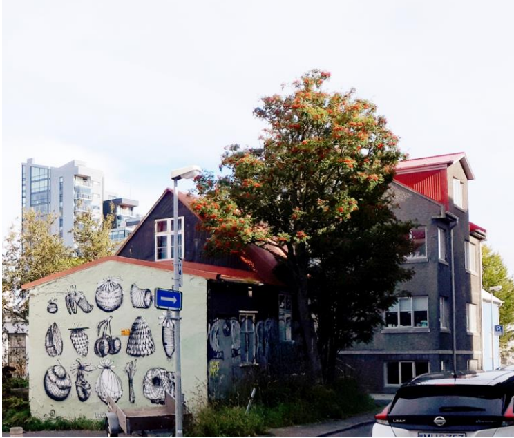
2022. Veghúsastígur 1 með skrautmáluðum gafl (dæmt ónýtt) og 1A (gráa steinhúsið) til hægri.
