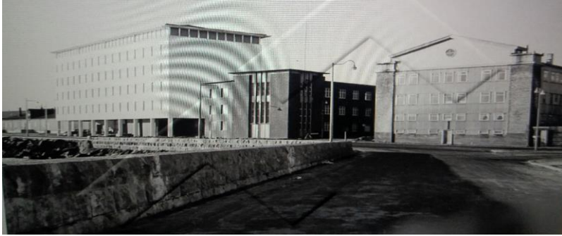
1960, Útvarpshúsið við Skúlagötu 4, hús Fiskifélagsins við Ingólfsstræti 1 og Sænska Frystihúsið við Kalkofnsveg 1 lengst til hægri / Ljósmyndasafn Reykjavíkur.
