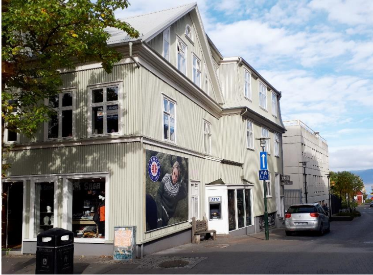
2022. Smiðjustígur í norður frá Laugaveg 11 allt að Bílahúsinu við Hverfisgötu 20 en á þeirri lóð stóðu áður húsin Smiðjustígur 1, 3 og 5.
