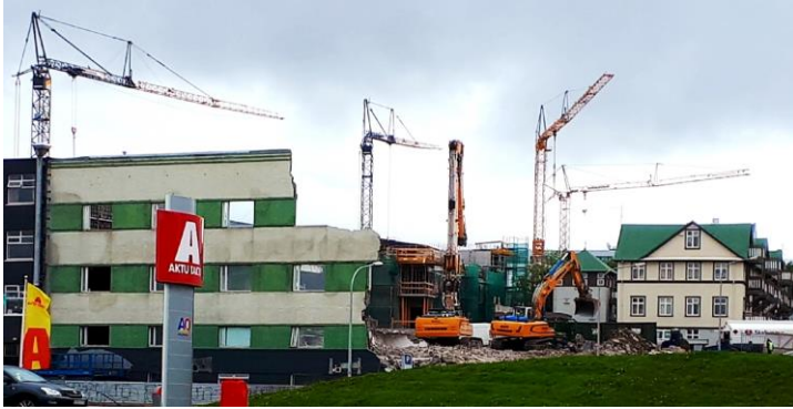
2018. Skúlagata 26 og Vitastígur 3 í niðurrifi. Lítið til austurs frá Vitatorgi. Hér mun rísa 17 hæða hótélbygging.
