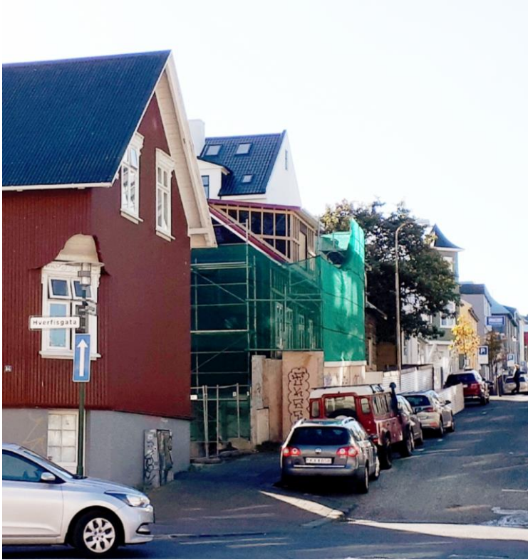
2022. Unnið að endurgerð húsa við austurhlíð Vitastígs (nr. 7, 9, 9a) ofan Hverfisgötu.
