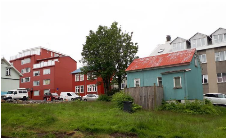
2022. Vatnsstígur 10-10A hafa verið rifin og ráðgert að flytja hús við Vatnsstíg 12 (bláa húsið) á lóð þessara húsa til að rýma fyrir stækkun stúdentagarða við Lindargötu. Rauðu húsin í bakgrunni eru Hverfisgata 49 og Vatnsstígur 9. Gráa steinhúsið er Vatnsstígur 11.
