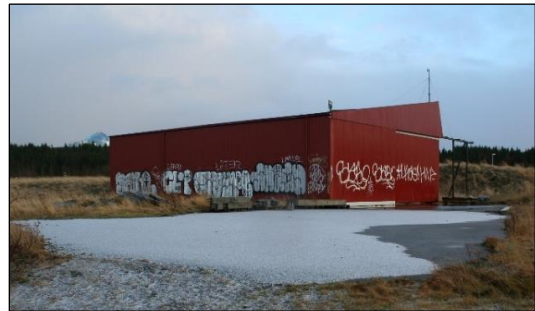
Mynd 119. Steypugrunn af veðurstofu hersins er væntanlega að finna undir þessu steypa plani. Horft í norðaustur.
