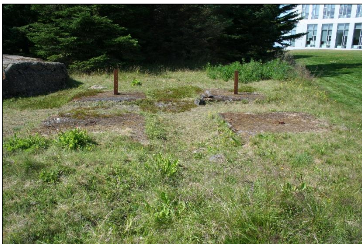
Mynd 66. Fjórir steyptir fletir (1999-20) sem voru undirstöður fyrir mastur við bæjarstæði Nauthóls, horft í norðvestur.
