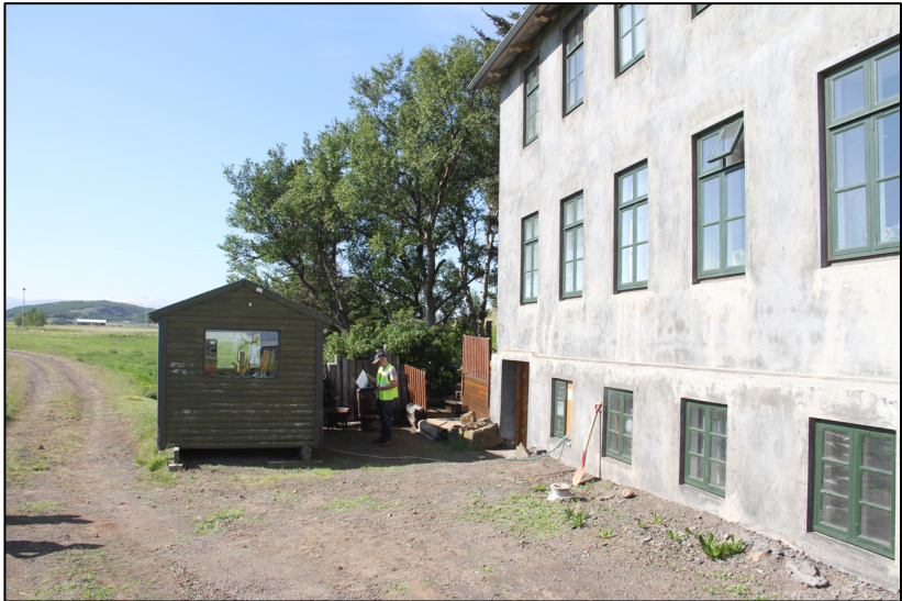
Mynd 2. Horft yfir svæðið áður en framkvæmdir hófust við lagningu ljósleiðara autan við Rangá 1.
