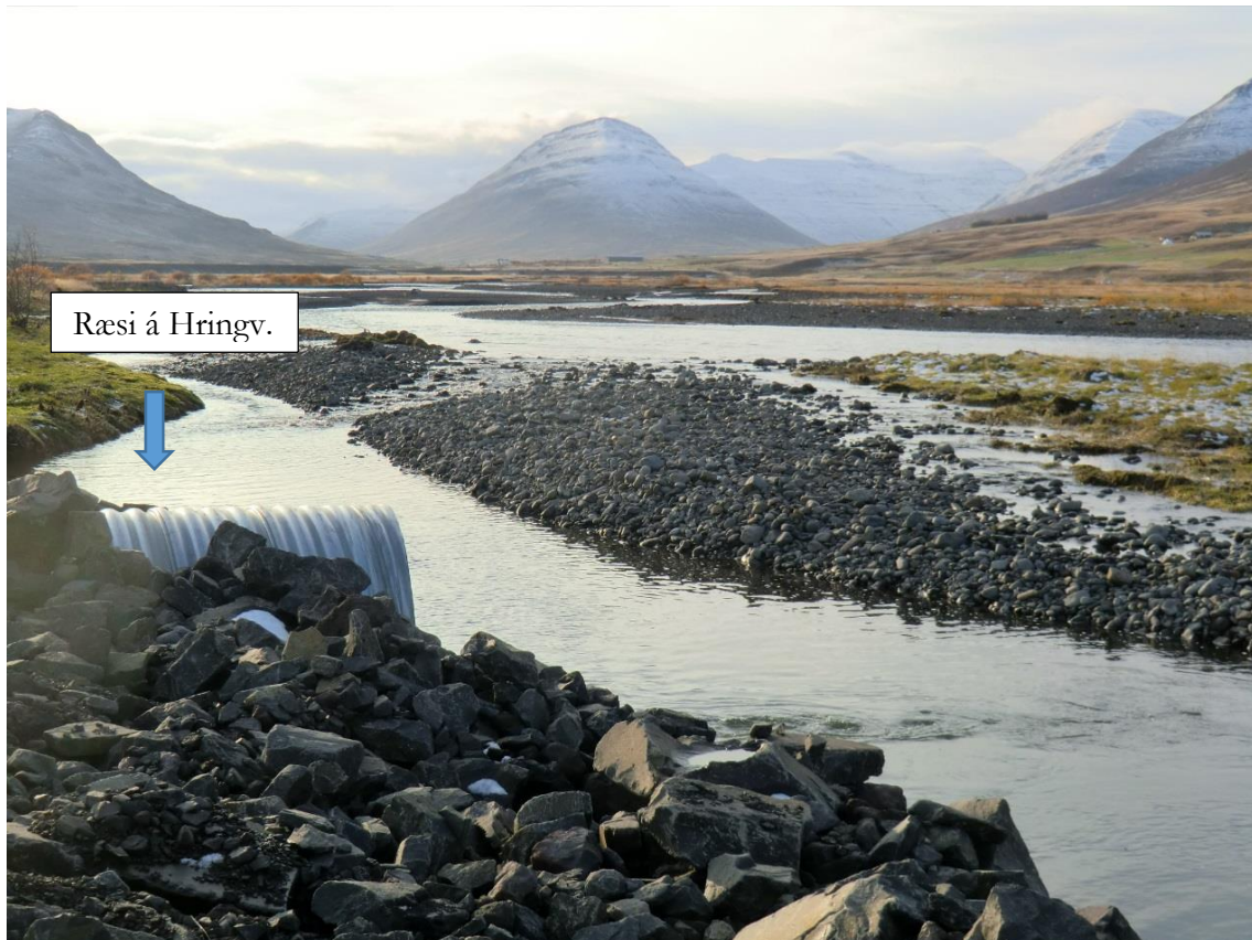
Mynd 6-16: Megin farvegur að færast til austurs að Hringvegi og árbotninn nánast að verða í sömu hæð og vegurinn. Svæði E9. Horft til suðvesturs (mynd GHG).
