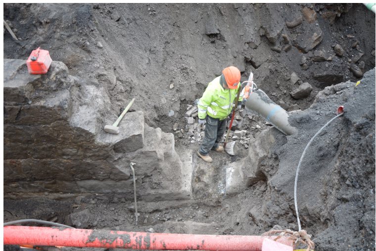
9 Gamalt lagnarof í grjóthleðslu vesturhliðar Steinbryggju. Sagað var nú úr neðstu steinaröð fyrir nýjum lögnum. Horft til austurs.
