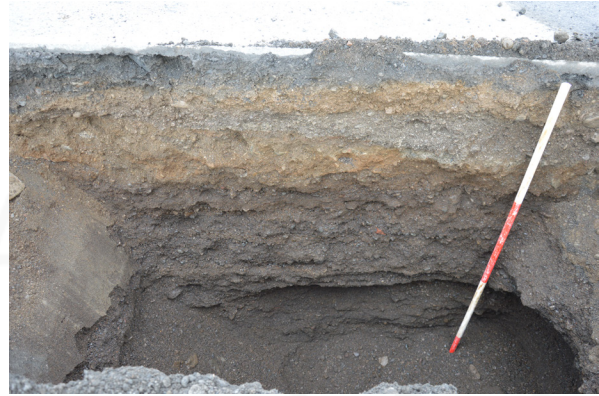
Mynd 6. Skurður 4 var 3x1m að stærð og snéri vest-suðvestur og aust-norðaustur. Dýpt hans var 210cm. Öll snið skurðarins voru einsleit. Efst undir malbiki var svokallað bögglaberg, undir því var hreyft moldarblandað malarlag og neðst var sendin sjávarmöl. Í norðursniði skurðarins var virkur rafmagnsstrengur á um 60cm dýpi. Engar fornleifar komu í ljós, hvorki gripir né mannvistarlög.
