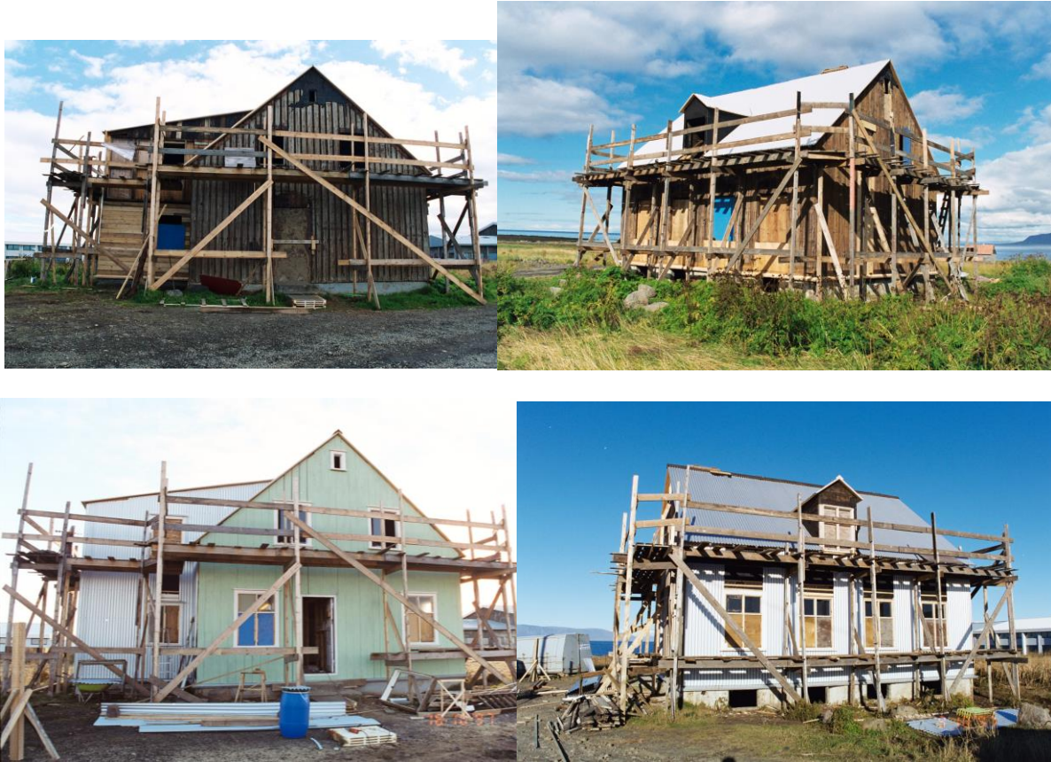
Mynd 9: Nokkrar myndir frá þeim tíma sem unnið var að því að gera húsið í Ráðagerði upp. Ljósmyndir Þorsteinn Bergsson
