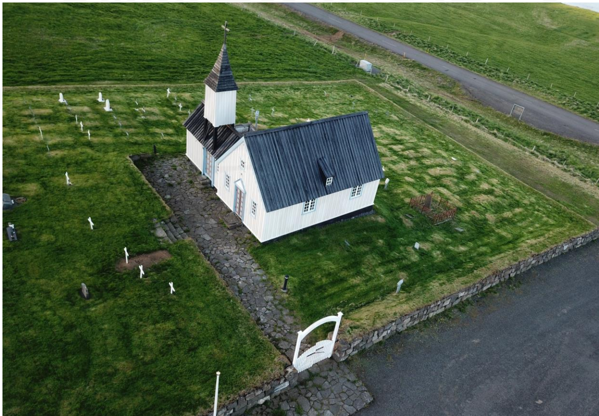
Skeggjastaðakirkja úr lofti, horft til norðausturs
