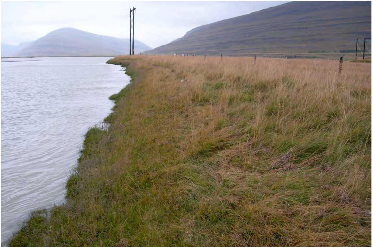
9. ljósmynd. Bakkavörn við Eyrarland við landbrotssnið Lb10. Hér hefur bakkinn verið klæddur gróðurtorfum sem komið hefur í veg fyrir landbrot. Ljós. Sigurður H. Magnússon, 29. sept. 2008.
