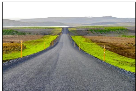
Mynd 13. Sáningar við Þeistareykjaveg
