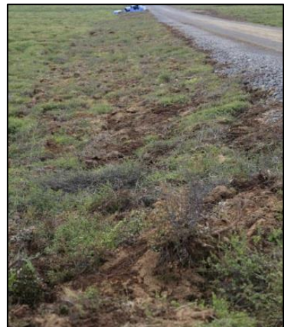
Mynd 7. Gróðurtorfur nýttar í vegkant.
