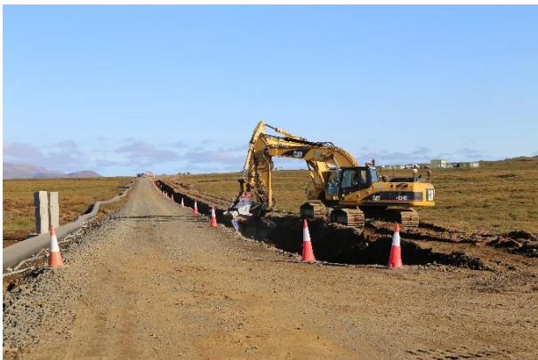
Mynd 16 – Lagning vatnsveitu.
