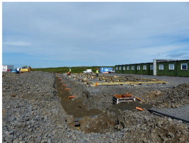
Mynd 37 – Undirbúningur fyrir skrifstofubyggingu.
