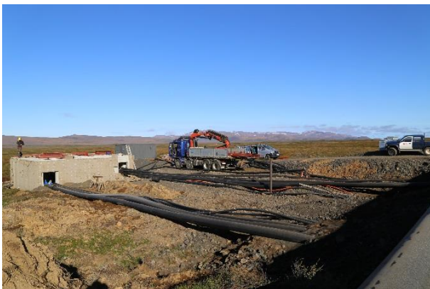
Mynd 18 – Bygging borvatnsveitu.
