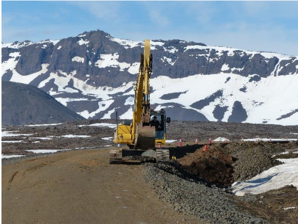
Mynd 14 – Lagning vatnsveitu.
