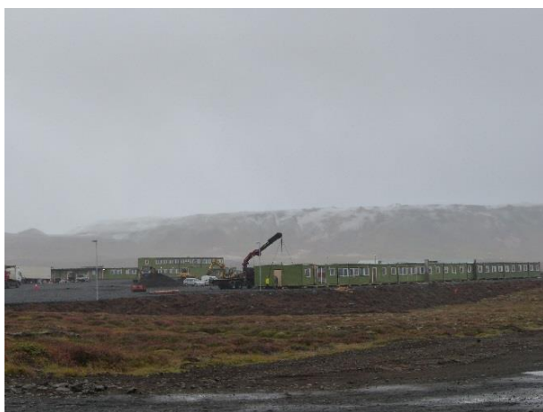
Mynd 38 – Hífting vinnubúða verktaka.
