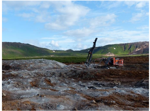
Mynd 5 – Talsverðar sprengingar þurfti við gerð grunnsins.
