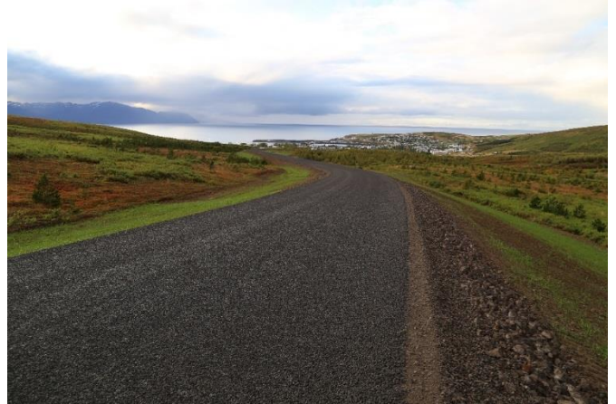
Mynd 22 – Eftir frágang vegflá og lagningu klæðingar.
