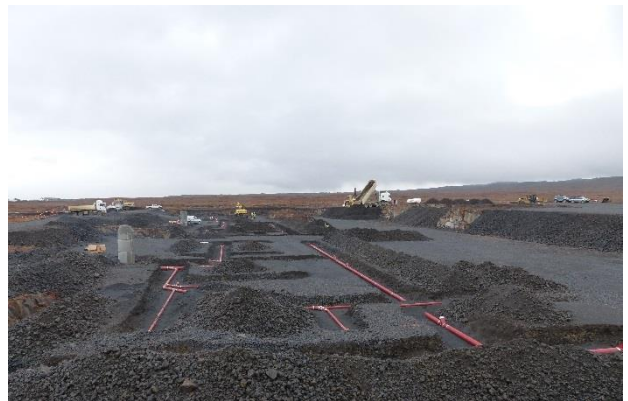
Mynd 7 – Lagnir í stöðvarhússgrunninum áður en honum var lokað.
