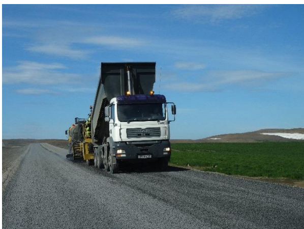
Mynd 29 – Lagning klæðingar.
