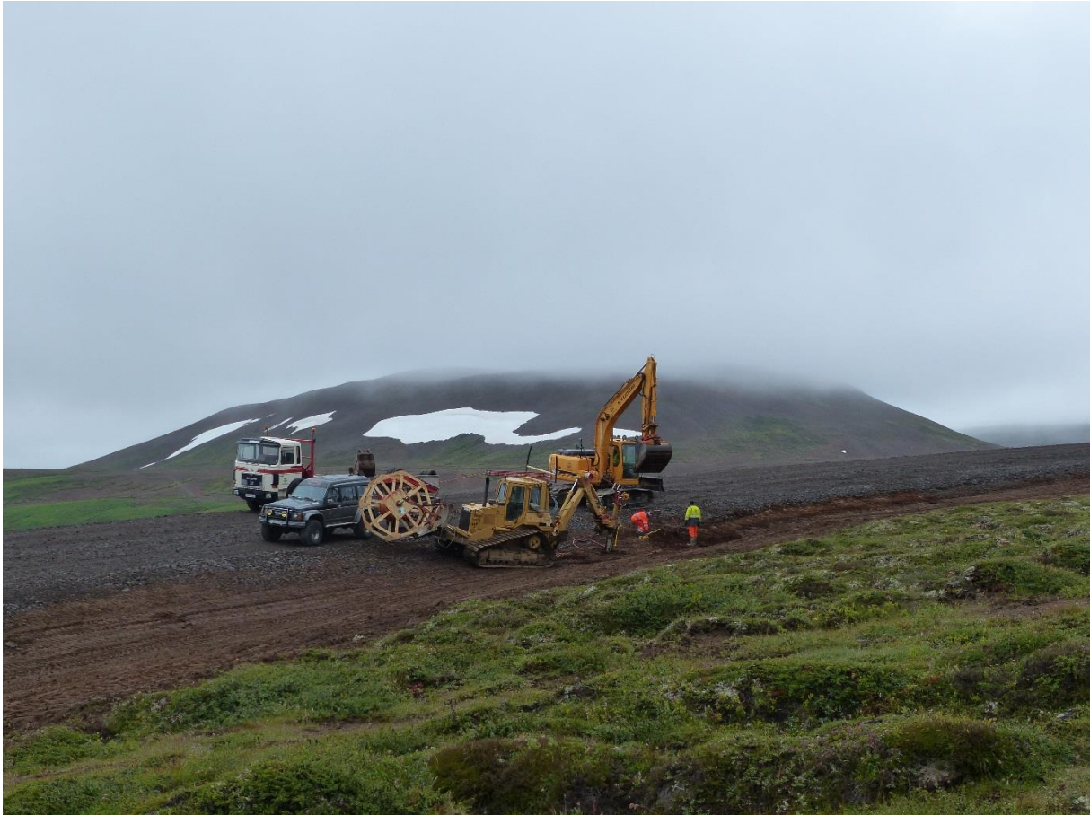
Mynd 35 - Lagning ljósleiðara frá Húsavík.
