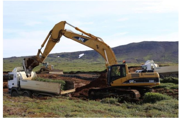
Mynd 9 – Svarðlag sett á vörubíl með grónu hliðina upp.
