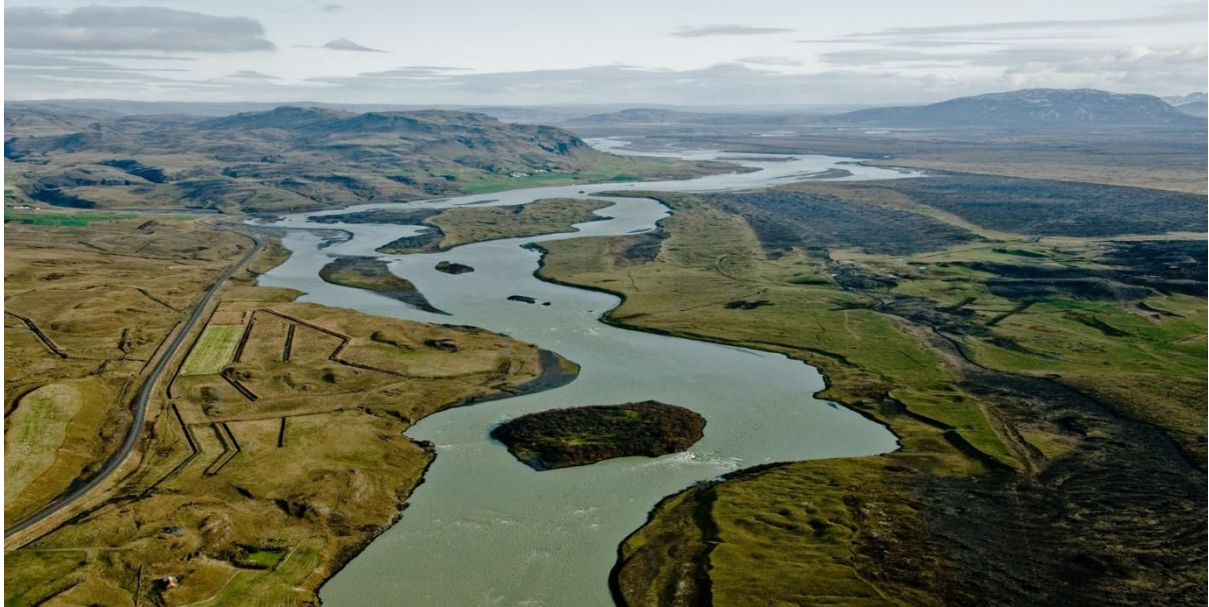
Mynd 1 Þjórsá – yfirlitsmynd. Horft í átt að fyrirhuguðu stíflustæði og inntaksskurði (ljósmynd: Landsvirkjun).
