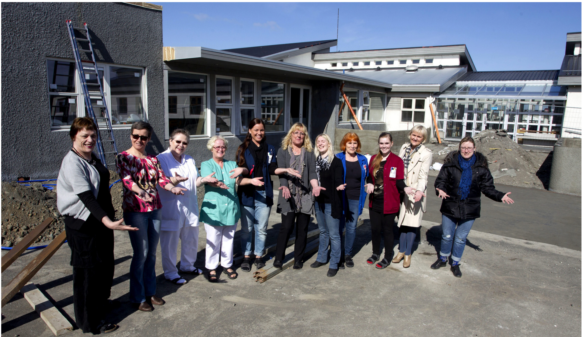
Sami hópur fyrir framan við nýbygginguna en hann tók fyrstu skóflustunguna fyrir rétt rúmu hálfu ári. Byggingin er eingöngu fjármögnuð með frjálsum framlögum og verður tekin í notkun nú í maí.
