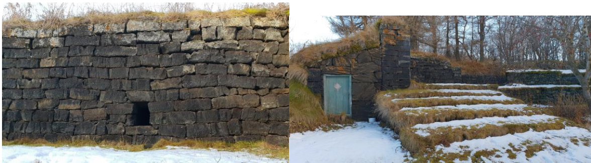
Hleðslur úr húsi Bárðar Sigurðssonar, SD-205:047. Á mynd til vinstri er horft til norðurs á fjósvegg og í honum sést gat sem var frá fjósi og yfir í „Skítahús“ norðan við. Á mynd til hægri sést Skítahúsið sem enn er undir þaki og tröppurnar upp í fjósið.
