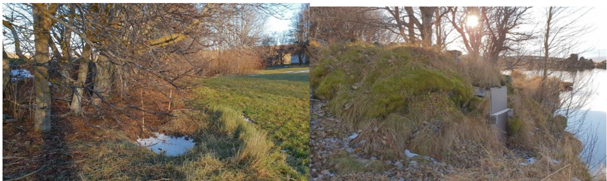
Brunnur SB-205:048. A mynd til vinstri er sjálfur brunnurinn (horft til norðurs) en dælubúsið á mynd til hægri (horft til suðurs).
