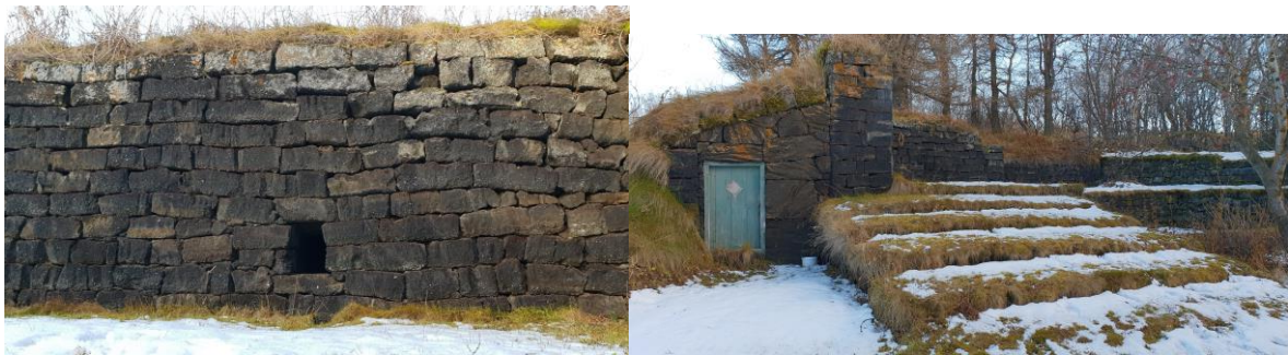
Hleðslur úr húsi Bárðar Sigurðssonar, SP-205:047. Á mynd til vinstri er horft til norðurs á fjósvegg og í honum sést gat sem var frá fjósi og yfir í „Skítahús“ norðan við. Á mynd til hægri sést Skítahúsið sem enn er undir þaki og tröppurnar upp í fjósið.
