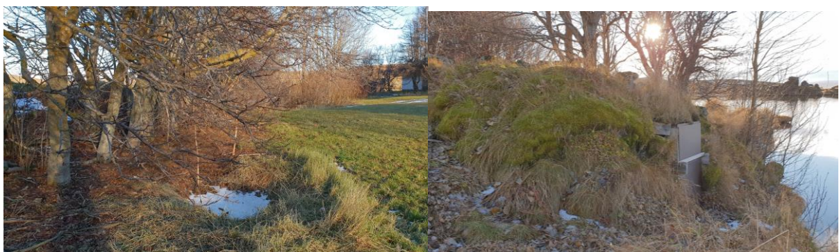
Brunnur SP-205:048. Á mynd til vinstri er sjálfur brunnurinn (horft til norðurs) en dælubúsið á mynd til hægri (horft til suðurs).
