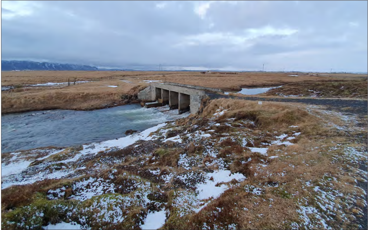
Volabrá er yfir Hróarsholtslæk, rétt sunnan við núverandi veg, skammt frá eyðibýlinu Vola á merkjum Hraungerðis- og Villingaholtshrepps. Hún var bæði stífla og brú líkt og sést á myndinni. ©Fornleifastofnun Íslands.
