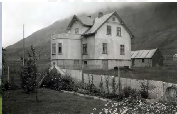
Gamla-Sýslumannshúsið á síðari hluta síðustu aldar eftir að búið var að forskala það. Höf. óp.
