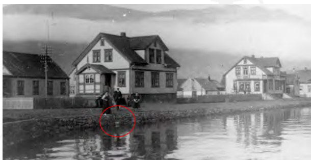
Á myndinni sést bólverk 249:480 meðfram Lóninu í smíðum og hefur ekki verið fyllt upp að því innanverðu suðvestan við Gíslahús. Innan rauðs hrings má greina vatnsrás og hefur brú 249:481 að líkindum legið yfir hana. Höf. óþ.
