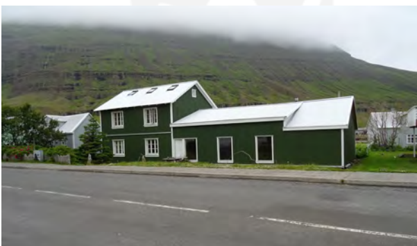
Waageshús 249:162, horft til norðvesturs. Elsti hluti hússins er í hægri megin á myndinni en húsið vinstra megin er tvílyft steinhús byggt við eldra húsið 1925.
