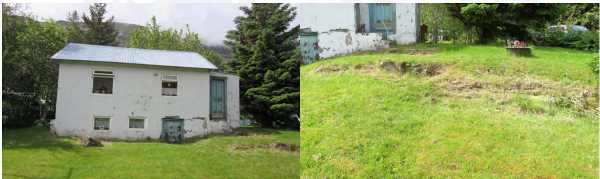
Bakki 249:290, horft til norðvesturs á vinstri mynd. Á hægri mynd er hlaðinn kantur við austurhorn hússins, horft til norðvesturs.
