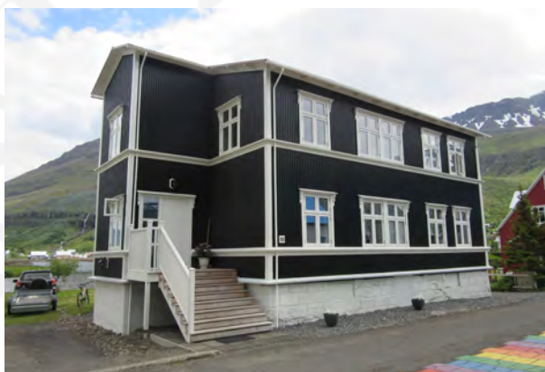
Kaupfélagið 249:282, horft til austurs.
