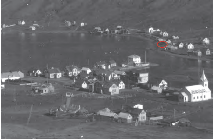
Svo virðist sem að hlaðinn kantur; bólverk NM-249:112 sjáist innan rauðs hringis á þessari gömlu mynd sem tekin er ofan við bæjarstæði Fjarðar NM-249:001. Höf. óþ.
