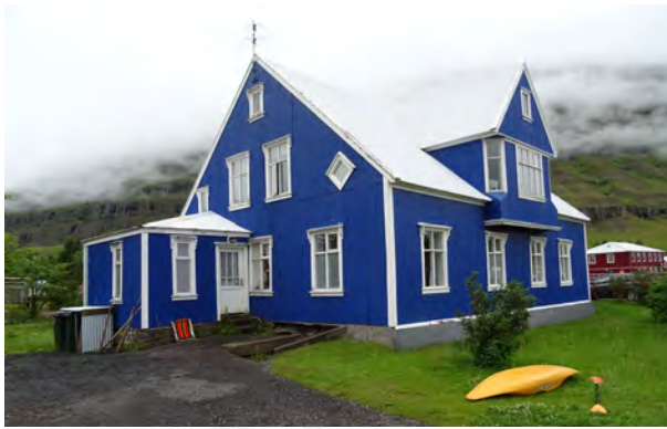
Apótekið 249:160, horft til VNV.
