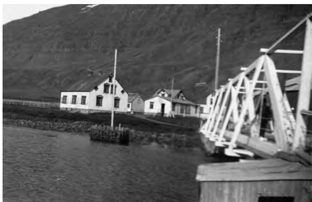
Á myndinni er horft til vesturs yfir Fjarðará að Sólvangi 249:272. Meðfram ánni sést grjóthlaðinn kantur sem ætla má að sé bólverk 249:246 sem lá frá Garvariinu 249:287 að brúnni yfir Fjarðará 249:028. Höf. óþ.
