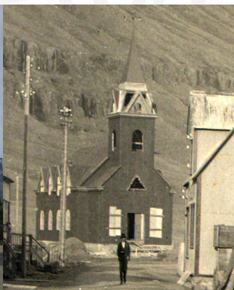
Á mynd sést Seyðisfjarðarkirkja í byggingu árið 1922. Höf. óp.
