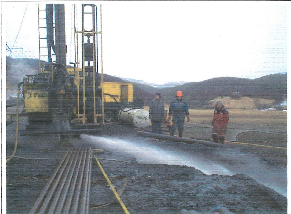
Borhola við Ásólfstaðir með 12 l/sek af 56°C heitu vatni (ljósm. Gestur Gíslason).
