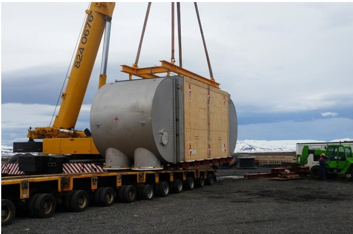
MYND 8 Eimsvali vélasamstæðu tvö frá Balcke-Dürr híður á geymslusvæði utan við stöðvarhús Þeistareykjavirkjunar. Ljósmynd: Landsvirkjun.
