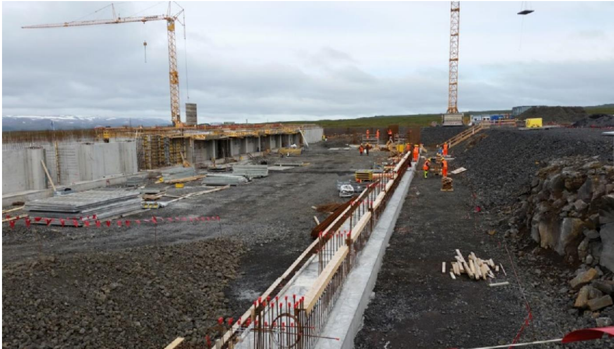
MYND 11 Bygging stöðvarhúss Þeistareykjastöðvar. Ljósmynd: Landsvirkjun.
