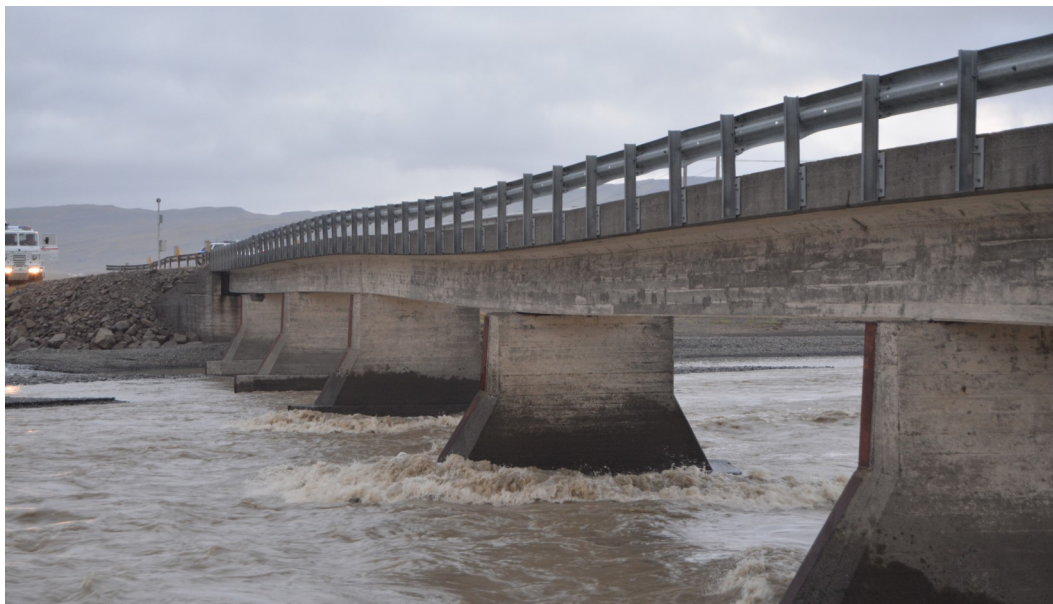
Brúin yfir Steinavötn (mynd frá Vegagerðinni)
