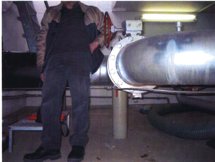
Mynd 12. Kranar inn – og úttak hægra megin við Halldór, fyrir neðan stóru gráuleiðsluna.
