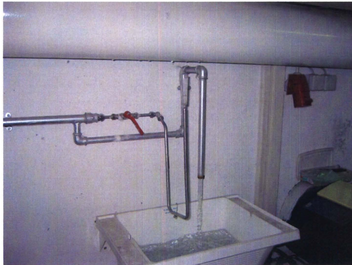
Mynd 14. Kjallari undir miðlunargeymi, vaskurinn með tækjum fyrir súrefnismælingar.
