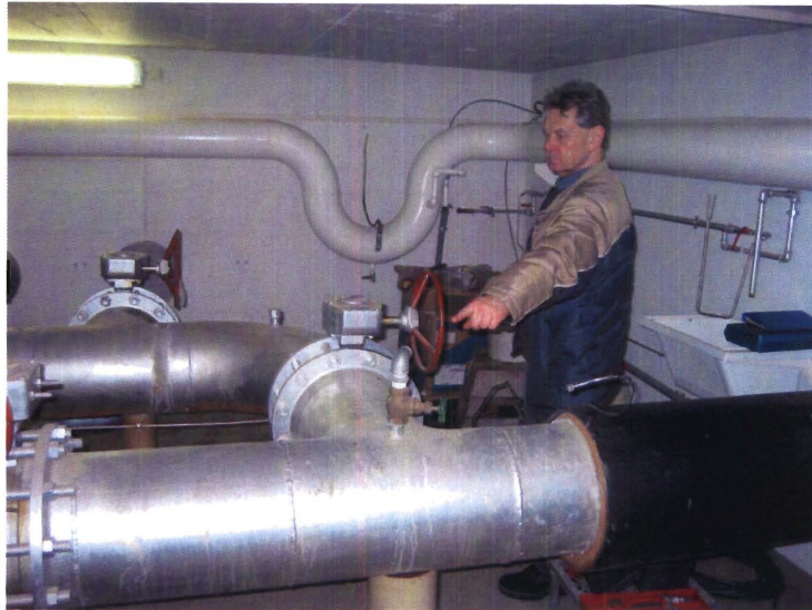
Mynd 11. Kjallari undir miðlunargeymi. Halldór bendir á úttak, sem er ekki virkt.
