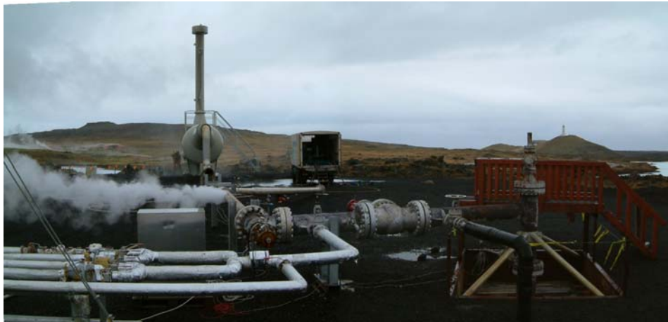
Mynd 3. Yfirlitsmynd af tilraunagreiðu þar sem sýnd er tenging við holu RN-11.
