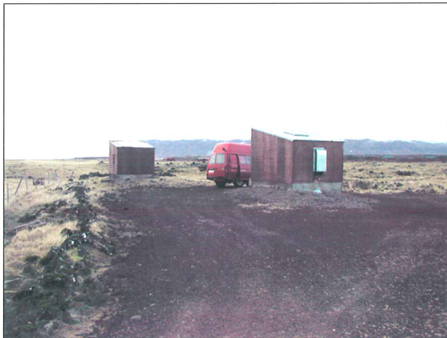
Mynd 5. Vaðnes. Hús yfir VN-13B í forgrunni.
