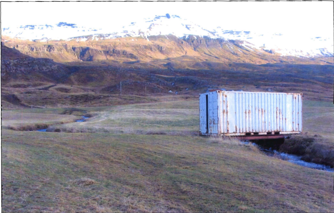
Mynd 2: Nýja stöðvarhús. Eldra stöðvarhús í baksýn
