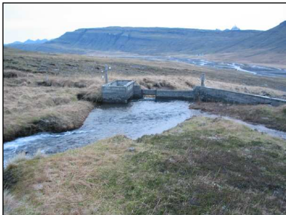
Mynd 8: Inntak gömlu virkjunar
