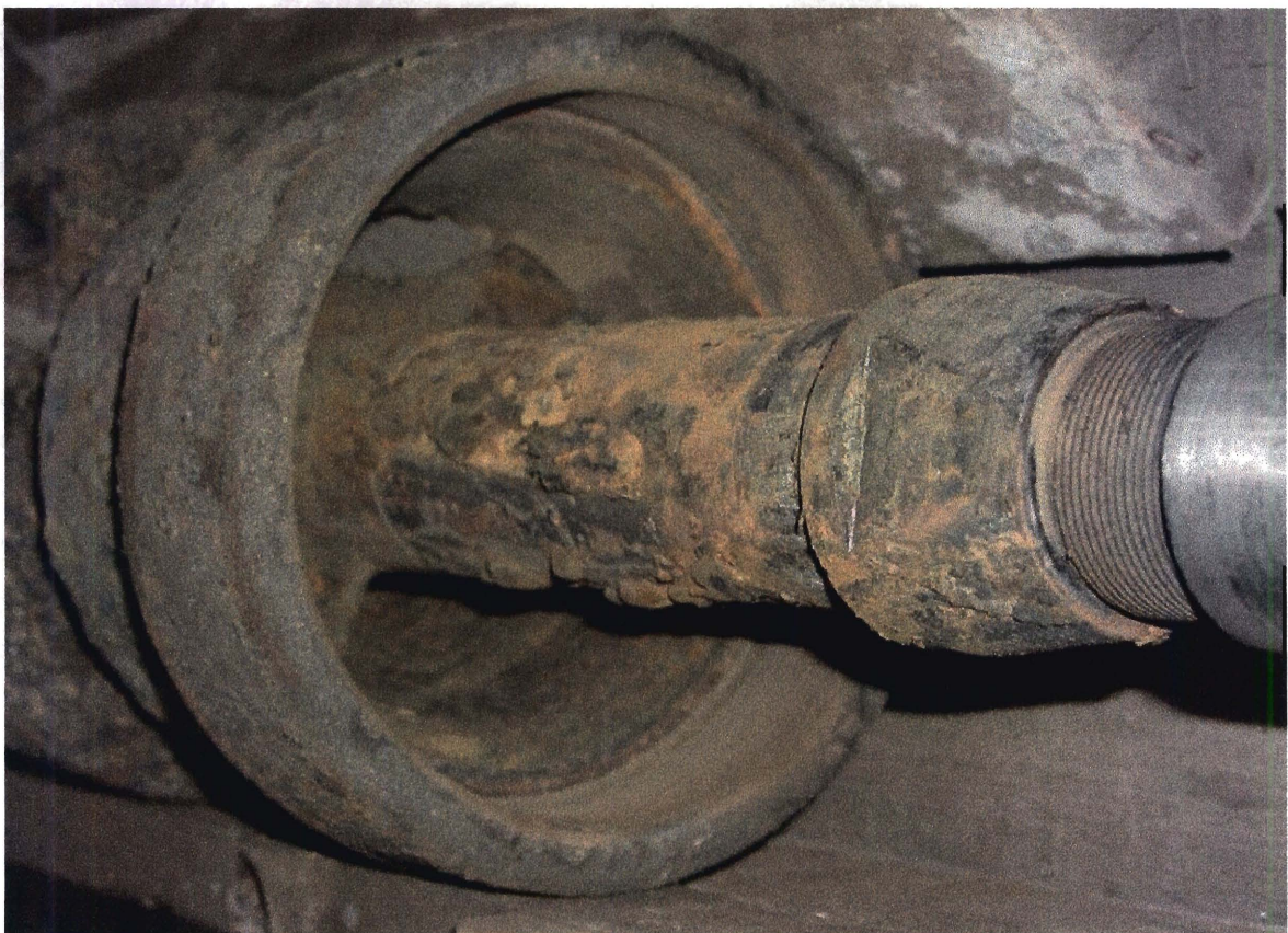
Mynd 7. Horft inn í dælu ofna frá, smurrör dæluöxla fyrir miðju. Tært að utanverðu - ryðbólur.
